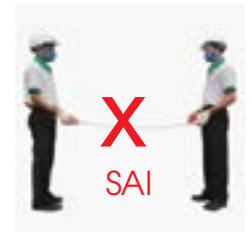
Tấm bị võng khi bốc xếp tấm ở tư thế nằm ngang.
